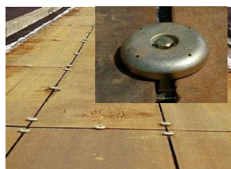
ダブルプレート養生
